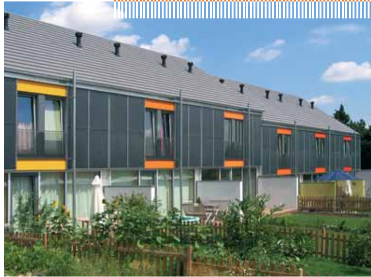
Fassadenkollektoren zur Warmwasserbereitung an den Passivhäusern der GeWoGe
