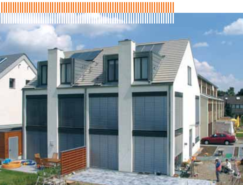
Doppelhaus mit Flachkollektoren zur Warmwasserbereitung
